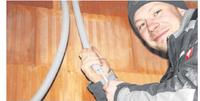
Der Innenausbau in der Jakob-Ertl-Gasse läuft: Derzeit verlegen die Handwerker in den 21 Wohnungen unter anderem die Leitungen und Rohre für Elektrotechnik und Heizung.
