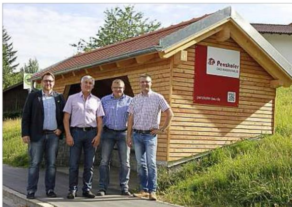
Freude über den neuen Unterstand: Gemeinderat Roland Stern (v.l.) und Bürgermeister Georg Fleischmann dankten Wilhelm Loibl, Leiter der Zimmerei bei der Penzkofer Bau GmbH, und Alexander Penzkofer, Geschäftsführer der Penzkofer Bau GmbH, für das neue Bushäuschen, das das Regener Bauunternehmen kostenlos für die Gemeinde baute. – Foto: Ebner
