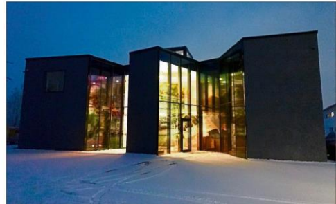
Das Haus besticht in der Nacht noch mehr durch die markanten Fensterfarben.
