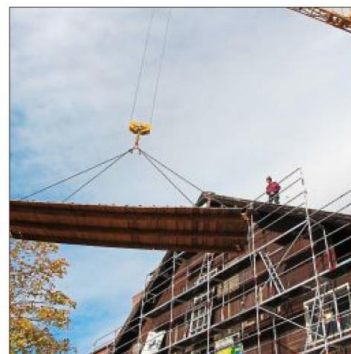
In Teile zerlegt wird die Holzkonstruktion des Dachstuhls für den Abtransport per Lastwagen.
