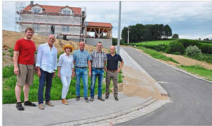
Ortstermin auf der neuen Erschließungsstraße: (v.l.) Stadtbaumeister Jürgen Schreiner, Planer Hans Beer, Bürgermeisterin Ilse Oswald, Jürgen Schaupp (Baufirma Schaupp), Stefan Paternoster (Penzkofer-Bau) und Toni Pöschl (Bayernwerk). Im Hintergrund das erste Einfamilienhaus im neuen Baugebiet „Am Grubhügel“, das schon fast fertig ist. – Foto: Kramhölter
