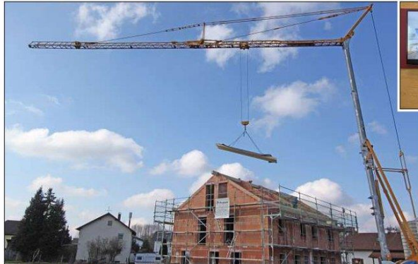
Innovative Technik am Bau: Penzkofer Bau setzt unter anderem auf ganze Redbloc-Wände oder Dachteile, die am Elementiertisch in der eigenen Zimmerei vorgefertigt werden, um Bauherren den Traum vom Massivhaus zu erfüllen, wie hier bei einem Doppelhaus in Niederaltreich. – Fotos: sk
