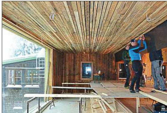
**Fleißig am Werkeln** sind beim Innenausbau die Mitglieder des Fördervereins. Die Innenwände in der Gaststube werden mit Altholz verkleidet.
