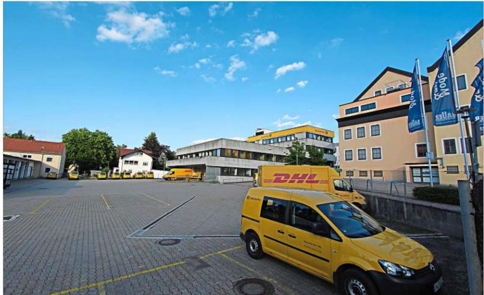
Viel Platz bietet das Post-Gelände, das seit rund acht Jahren nicht mehr der Post gehört. Jetzt haben es Regener Unternehmer gekauft und wollen auf den 7300 Quadratmetern Einzelhandelsflächen entwickeln. – Fotos: Ebner
