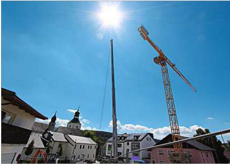
Regens Türme: Fast unmittelbar neben dem Kirchturm wurde der Obendreherkran in der Amtsgerichtstraße für den Bau der neuen Wohnanlage an der Jakob-Ertl-Gasse aufgebaut. – Foto: Ebner
