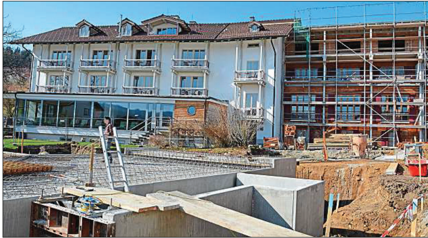
Zwei Baustellen im Parallelbetrieb befinden sich derzeit auf dem Gelände des Hotels St. Florian. Im Bestandsgebäude (rechts im Hintergrund) wird der Dachboden ausgebaut, um Platz für neue Zimmer zu schaffen. In Richtung der „Gläsernen Gärten“ (im Vordergrund) wächst derweilen das „Garten-Spa“ empor. – Fotos: Hackl
