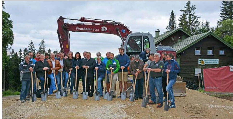
Viele Gäste aus den Reihen des Wald-Vereins, vom Förderkreis, von der Baufirma sowie Architekten und Vertreter der Politik freuten sich mit Wald-Vereins-Präsident Helmut Brunner (Mitte) über den Spatenstich zum Neubau des Falkenstein-Schutzhäuses. – Fotos: Winter
