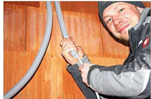
**Der Innenausbau** in der Jakob-Ertl-Gasse läuft: Derzeit verlegt das Penzkofer-Team in den 21 Wohnungen unter anderem die Leitungen und Rohre für Elektrotechnik und Heizung.
