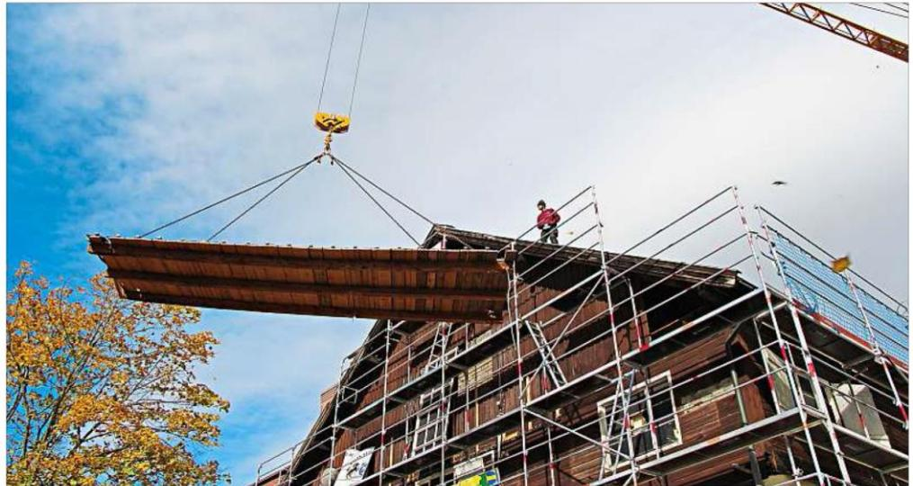
In Teile zerlegt wird derzeit die Holzkonstruktion des „Tanzboden“-Dachstuhls für den Abtransport per Lkw.
