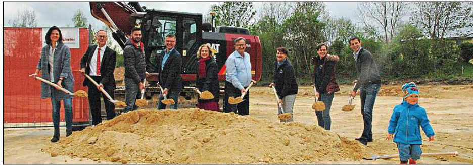
Beim Spatenstich zum neuen Gebäude: (v. links) Architektin Kathrin Bollwein, Otto Kufner (Sparkasse), Bauleiter Thomas Kuffner und sein Chef Alexander Penzkofer, Bürgermeisterin Ilse Oswald, Klaus und Susanne Hock, die Geschwister, Geschäftsführer und Hauptgesellschafter Eva-Maria Hock-Szargan und Franz-Josef Hock und Hock-Szargans Sohn René.
