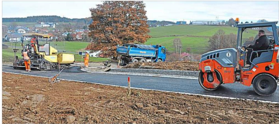
Optimales Wetter zum Asphaltieren hatten die Bauarbeiter der Deggendorfer Baufirma Schaupp am gestrigen Dienstag. Die neue, rund 200 Meter lange Straße verbindet Arberstraße und Kronbergweg, die bisher beide als Sackgassen endeten. – Foto: Fuchs
