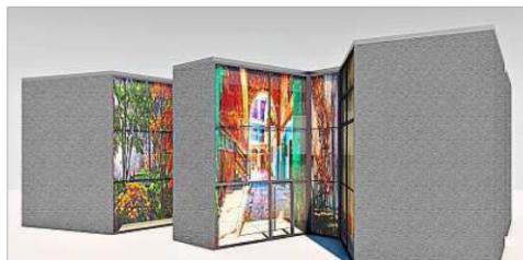
Innovativer Neubau: So könnte das Bürogebäude später ausschauen. Von dem rechteckigen Gebäude wurden an der Vorderseite beim Bau drei Dreiecke ausgespart. Die Front wird komplett mit Glas verkleidet – und später mit bunt-bedruckten, transparenten Folien gestaltet. Eine Besonderheit ist auch die spezielle Wärmedämmfassade mit anthrazitfarbenem Putz und metallischem Anstrich. – Illustration: Rebl
