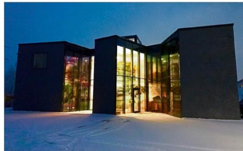
Das Haus besticht in der Nacht noch mehr durch die markanten Fensterfarben.
