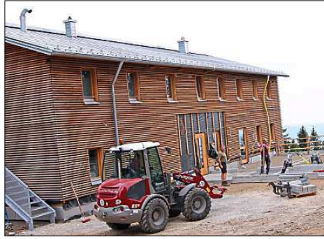
In den vergangenen Tagen wurde die finale Phase der Bauarbeiten eingeläutet, unter anderem mit der Sonnenterrasse an der Südwestseite des neuen Schutzhauses auf dem Großen Falkenstein. – Foto: Zens
