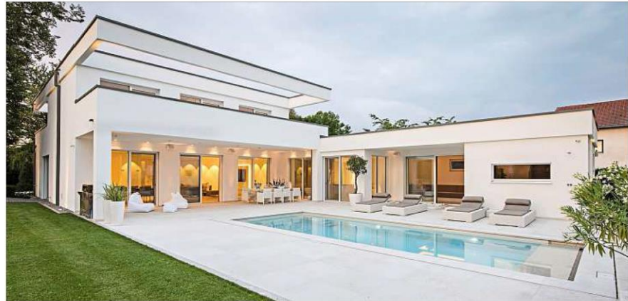
Modernes Design: Klare Linien, viel Glas und die markante Gebäudeform sorgen in dem Massivhaus für viel Weitblick.
