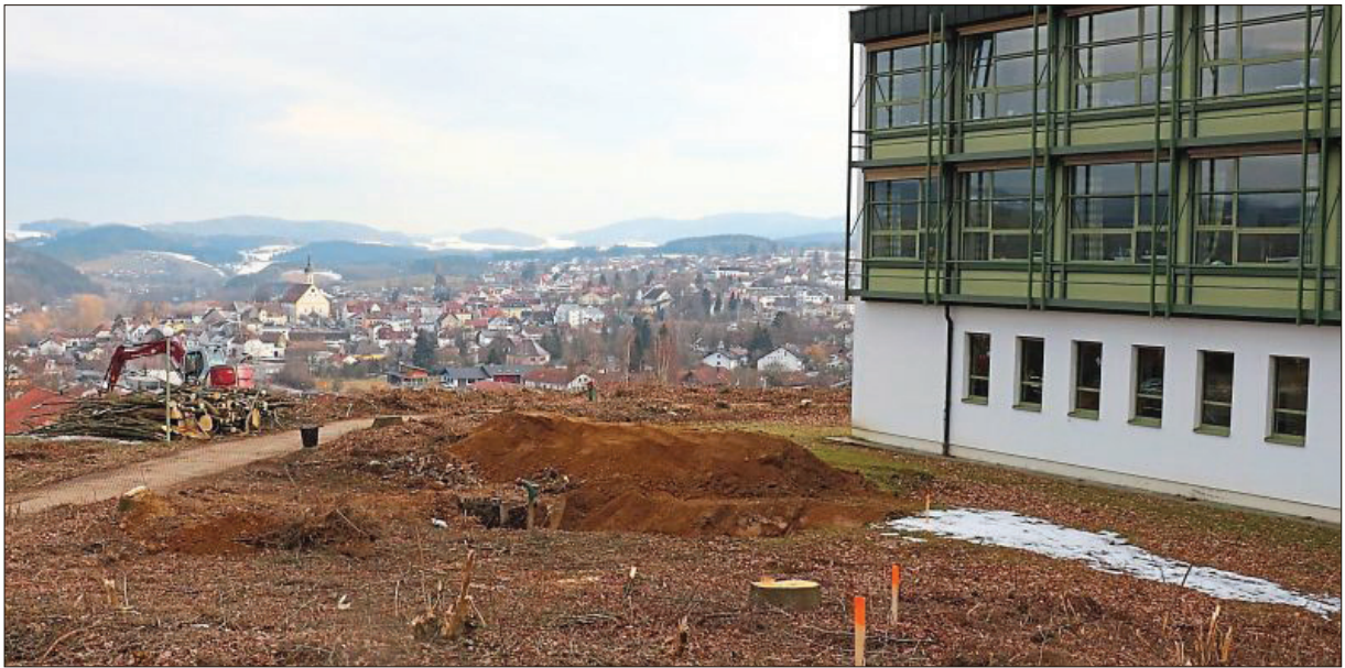
Bäume wurden bereits gefällt und eine Zisterne umgelegt. Derzeit laufen die Vorarbeiten für den Bau des Facharztzentrums neben der Arberlandklinik Viechtach. Foto: Bäumel
