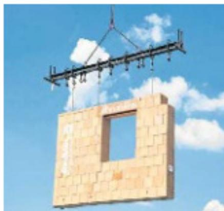
**Die fliegenden Wände: Mit Hilfe eines Krans gelangen die fertigen Ziegelwände auf der Baustelle aus der Luft an ihren Platz. Eine vollautomatische Fertigung von kompletten Wandflächen wie bei der Redbloc Elemente GmbH ist in Deutschland einmalig.**
