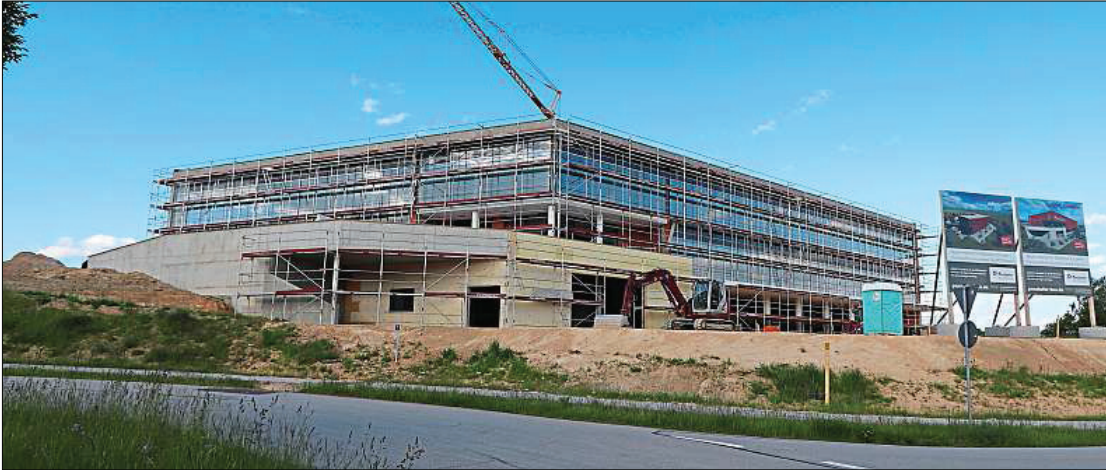
Gut im Zeitplan: Der neue Firmensitz der Penzkofer Bau GmbH im Gewerbegebiet Metten wächst zügig. Ab Anfang 2021 soll schrittweise das komplette Unternehmen vom jetzigen Standort Oleumhütte an diesen Standort verlagert werden. – Foto: Ebner
