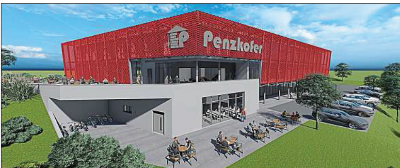
Architektur der anderen Art: So soll das Bürogebäude ausschauen. Ins Auge sticht die lichtdurchlässige, purpurrote Flexbrick-Ziegelfassade. – Illustration: wp Gesellschaft von Architekten mbH, Regen
