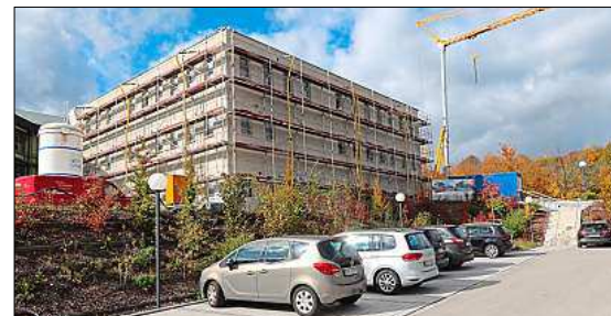
Der Rohbau des neuen Gesundheitszentrums steht: Patienten, Ärzte und Therapeuten können sich auf moderne Praxis- und Therapie Räume auf vier Etagen freuen – samt direkter Anbindung an die Arberlandklinik Viechtach. – Fotos: Susanne Ebner
