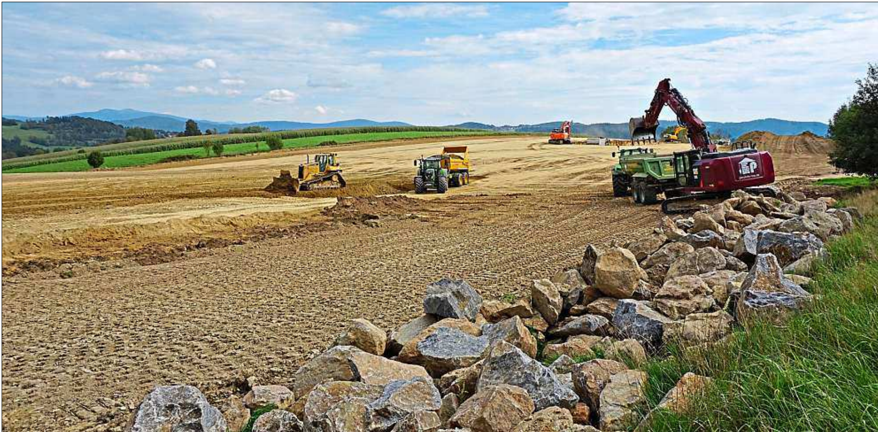
Auf der derzeit größten Tiefbau-Baustelle in Regen wird kräftig gebaggert und planiert. Auf dem rund 35 000 Quadratmeter großen Areal entsteht der neue Firmensitz der Penzkofer Bau GmbH. – Foto: Lukaschik
