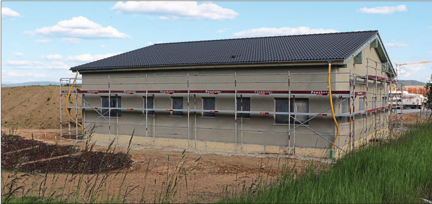
Das Technik-für-Kinder-Haus im Gewerbegebiet Metten. Der Rohbau steht schon.
