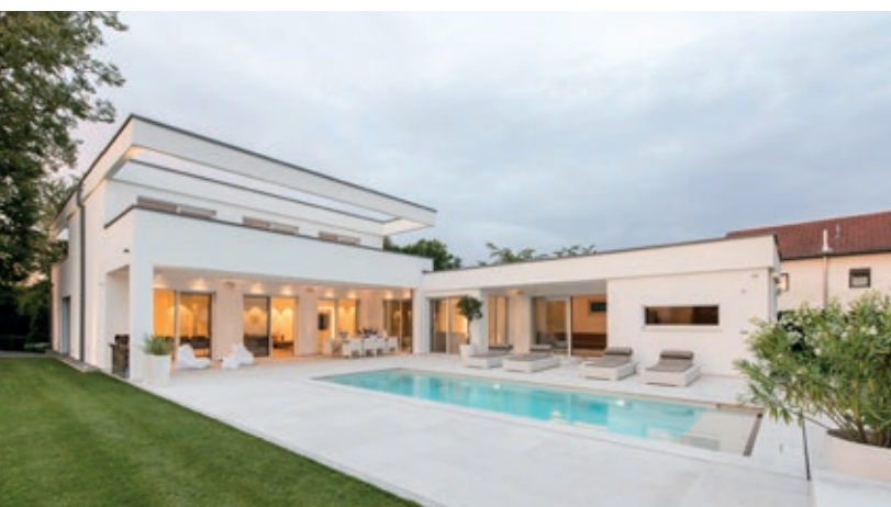
Wohnhaus, Landkreis Dingolfing-Landau
