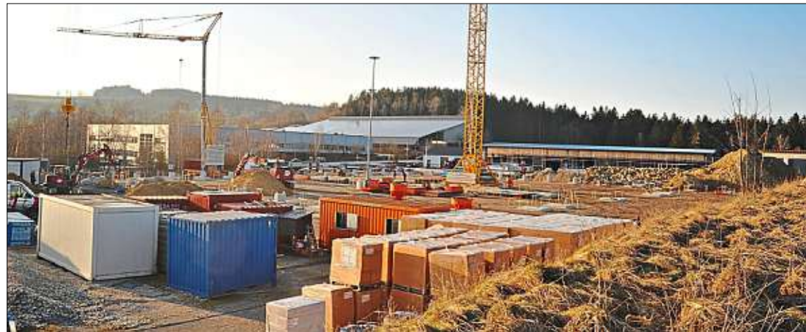
Bauen für den Holzbau: Auf dem Penzkofer-Gelände im Gewerbegebiet Metten entsteht eine große Halle, in der demnächst Wände für den Holzbau vorgefertigt werden.
