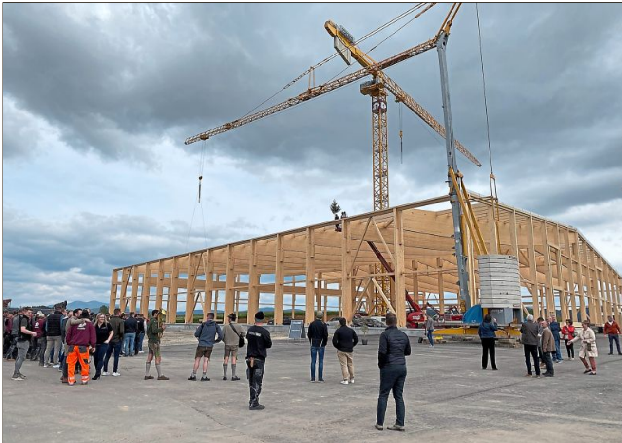
Der Firstbaum steht! Am Mittwoch fand das Richtfest statt.
