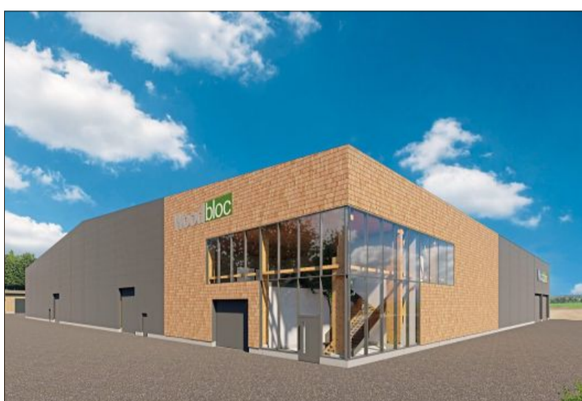
So soll die fertige Produktionshalle einmal aussehen.
