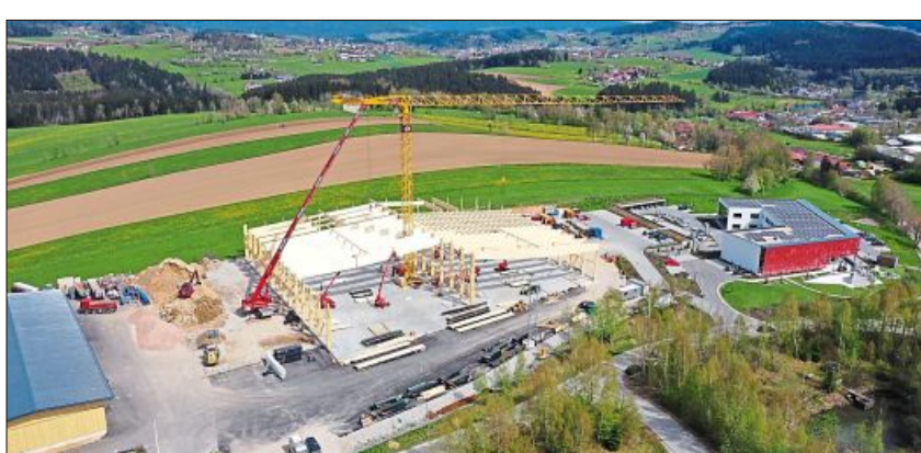
In wenigen Monaten soll die Halle fertig sein.
