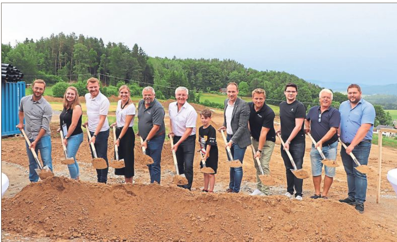
Symbolischer Baustart für das neue Wohngebiet am Gießhübl: Miteinander griffen die Gotteszeller Bürgermeister, die Vertreter der Penzkofer Bau GmbH, die früheren Grundstückseigentümer sowie Gemeinderäte und Partner zu den Spaten.
