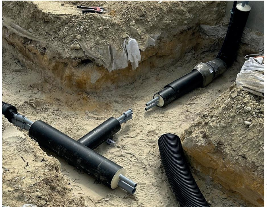
Die Multifunktionsrohre werden samt Mediumrohr und Schutzschlauch in der Erde verlegt.
